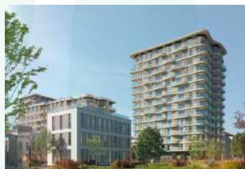
Жилой комплекс Лаврушинский
